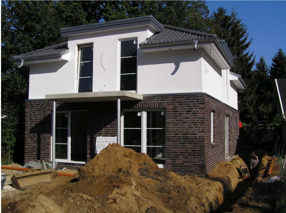
Die Hausanschlüsse (Strom, Telekom, Gas Wasser) werden in das Gebäude gelegt
