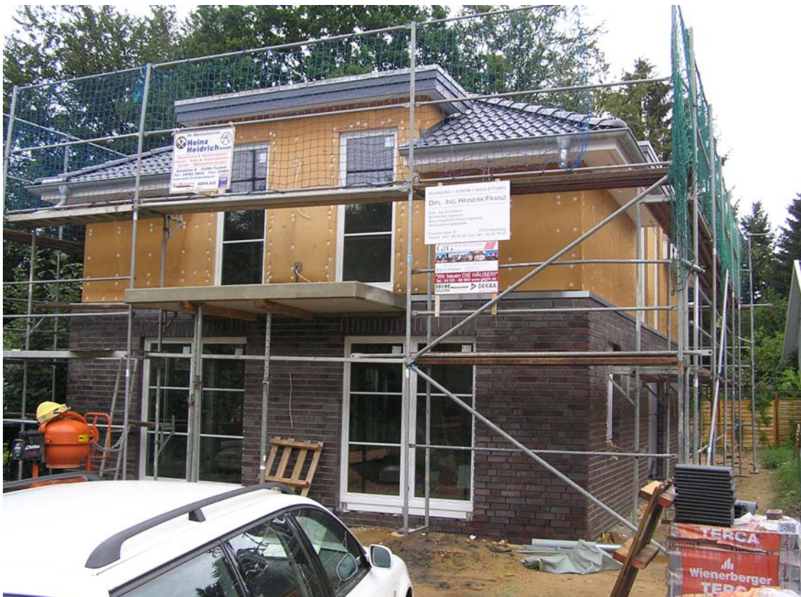
Obergeschoss ist fertig, die Fenster sind montiert.
