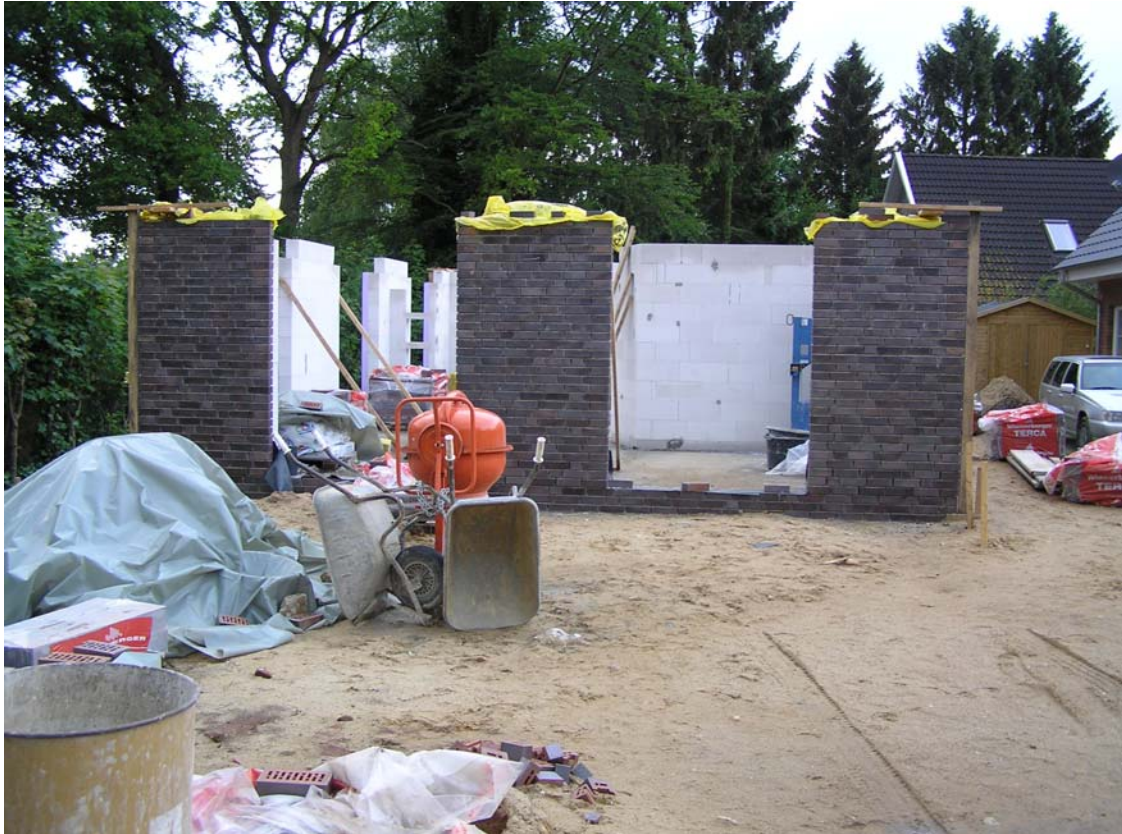
Das Erdgeschoss ist fertig.
